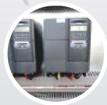
Controle de velocidade dos motores com comunicação em rede
