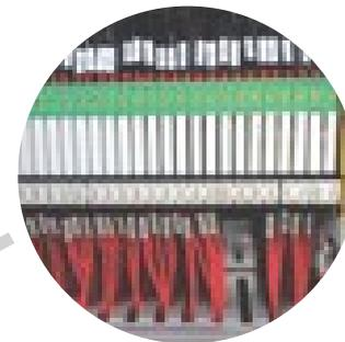
Opto-acopladores para isolamento das I/O's do CLP e Relé de segurança atendendo NR-12
